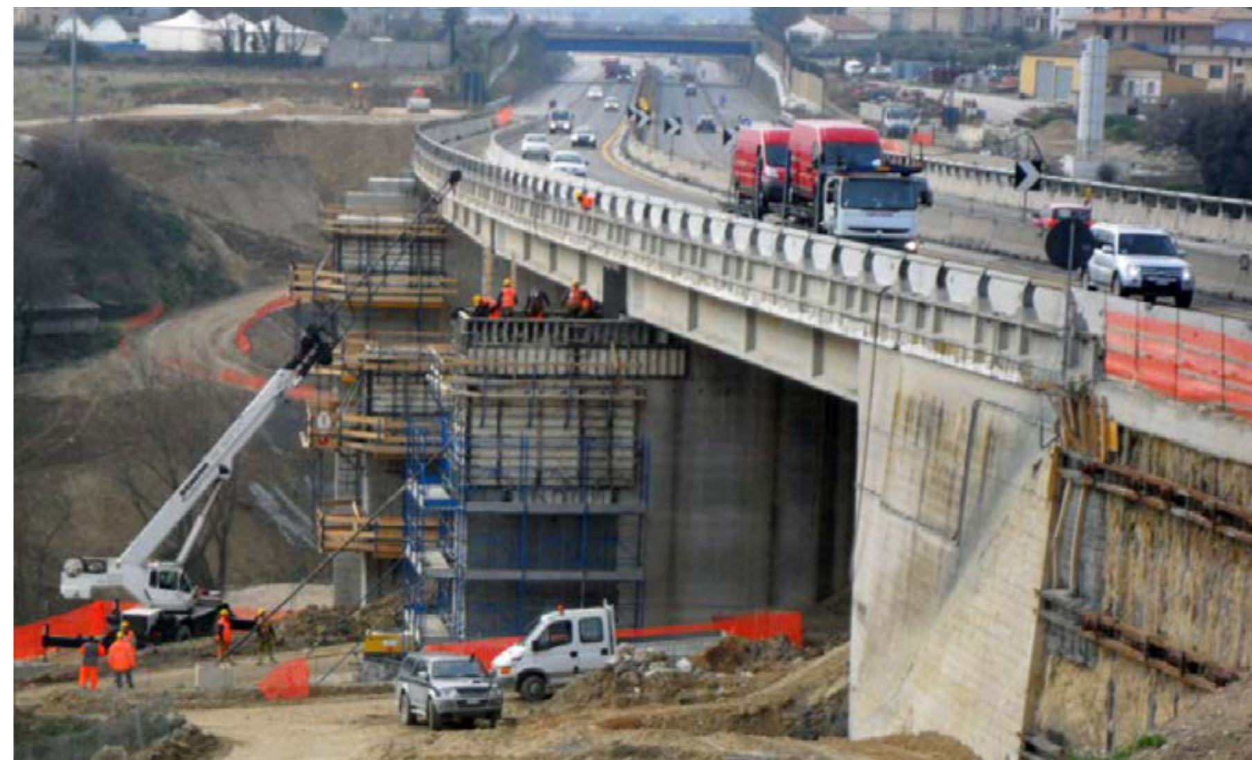
Cantiere Porto Sant'Elpidio
