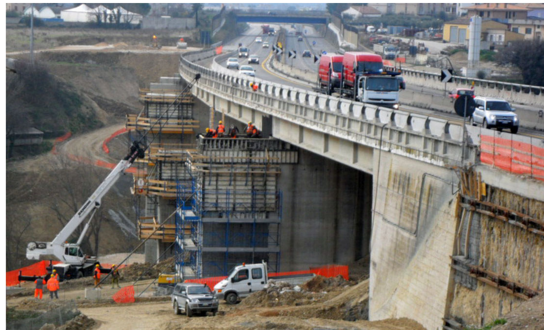
Cantiere Porto Sant'Elpidio
