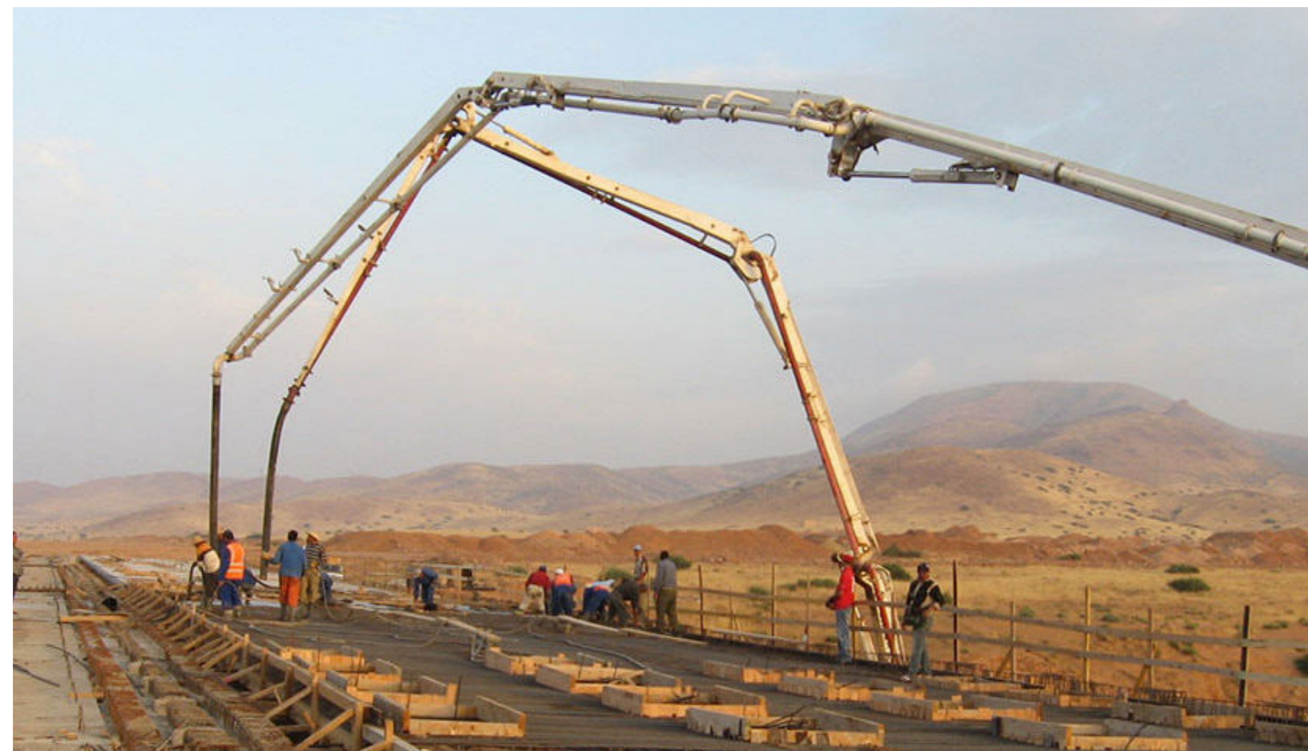
Committente: Marocco Lavori presso Taza Oujda
